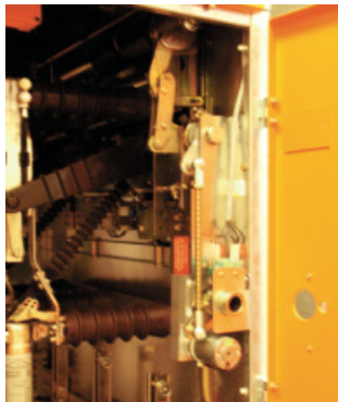
Beispiele eingebauter Motorantriebe: links in einem Trafoschaltfeld, rechts in einem Kabelschaltfeld
