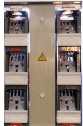
Abb. 8: Sammelschienenabdeckung
