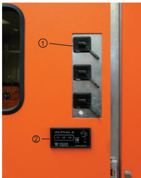
Bild: D-Feld mit kapazitiver Schnittstelle und Kurzschlussanzeiger
